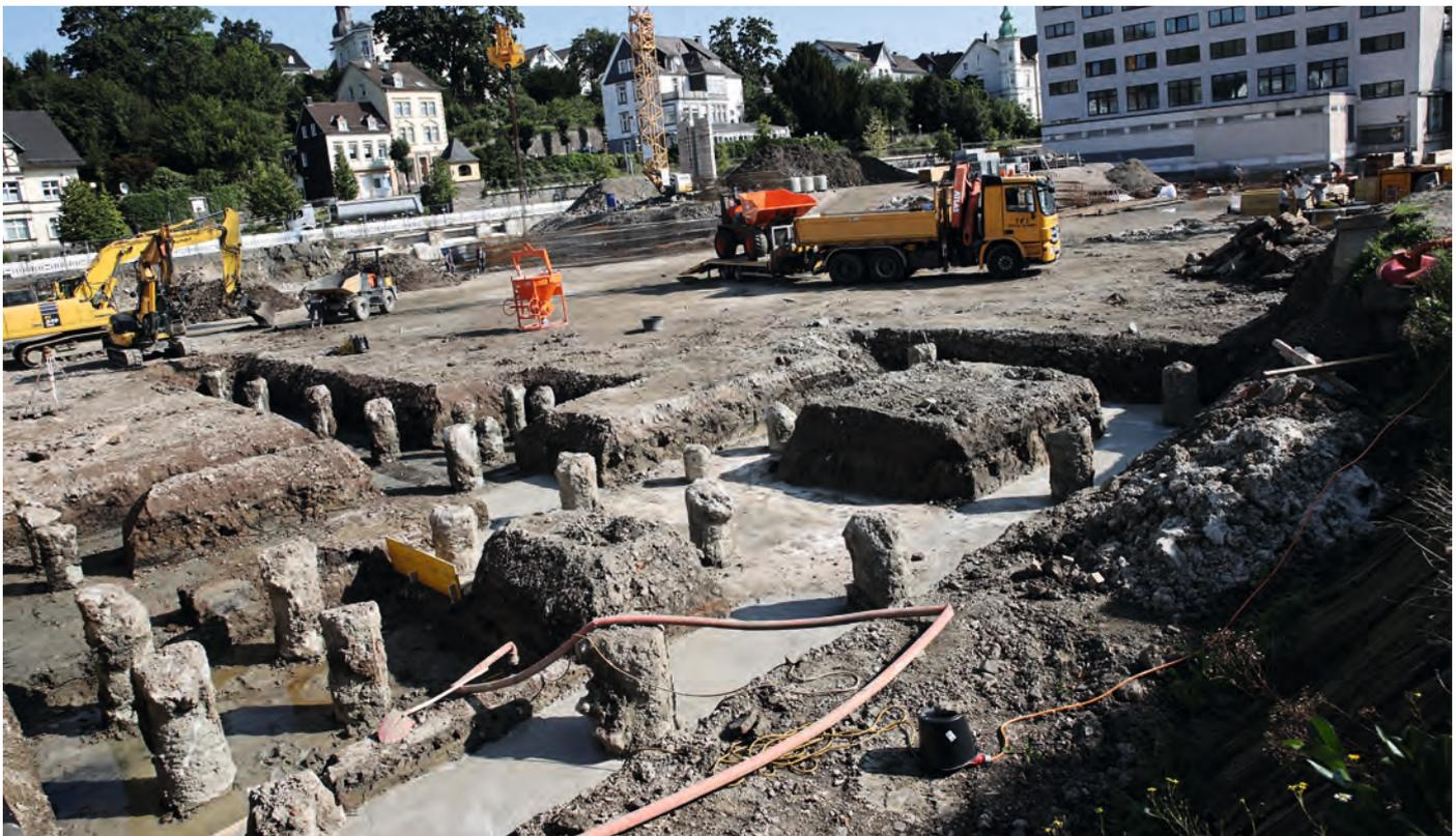
Was aussieht wie eine Ausgrabungsstätte altertümlicher Ruinen sind die unterirdischen Betonpfeiler, die im Sommer mit dem großen Bohrturm verankert wurden. Diese werden jetzt im oberen Teil freigelegt, um mit einer Bodenplatte aus Beton verbunden zu werden. Später ruht darauf das Fundament der neuen Gebäude.
