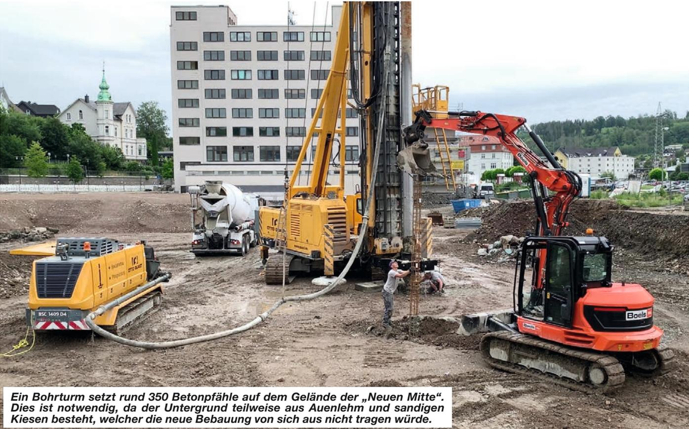
**Ein Bohrturm setzt rund 350 Betonpfähle auf dem Gelände der „Neuen Mitte“. Dies ist notwendig, da der Untergrund teilweise aus Auenlehm und sandigen Kiesen besteht, welcher die neue Bebauung von sich aus nicht tragen würde.**
